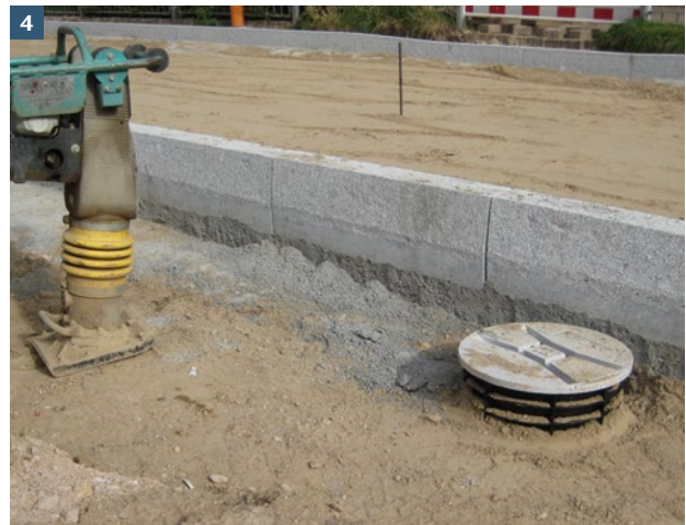
4 Verfüllen nach DIN EN 1610 mit entsprechendem Verfüllmaterial nach DIN 18196. Verdichten mit leichtem Verdichtungsgerät bis zur Markierung „Unterkante Beton“ auf dem obersten Kunststoffelement.
