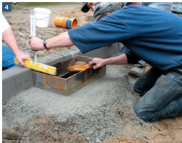
4 Aufsatzrahmen ca. 2 cm in Betonbettung eindrücken bei gleichzeitiger Beachtung der Endhöhe.
